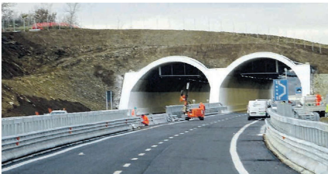
TRASVERSALE L'ultimo tratto realizzato
